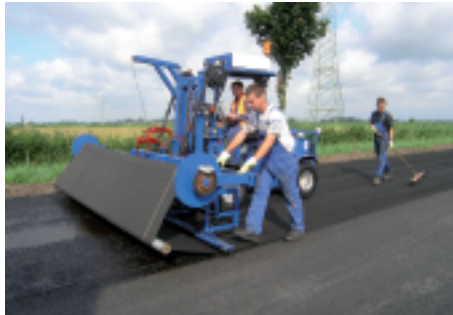
Einbau der Asphaltbewehrung
